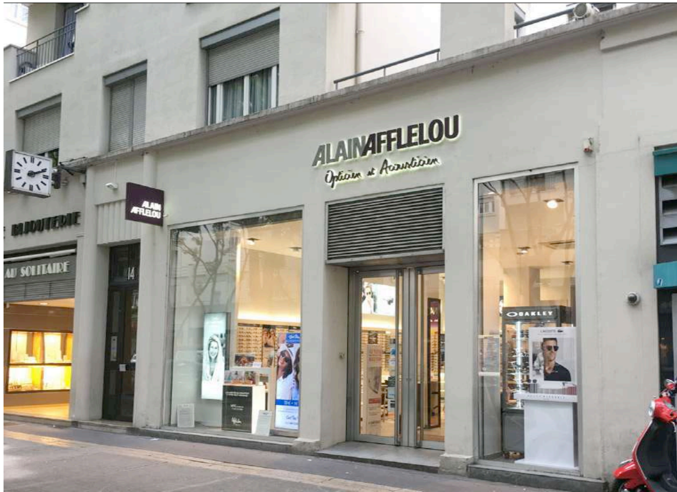
AP 6 FAÇADE EXISTANTE
